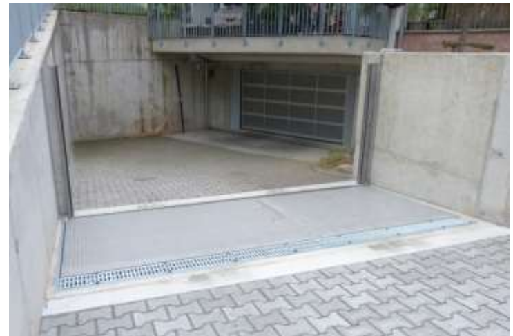
Nach der Montage – einsatzbereit!
