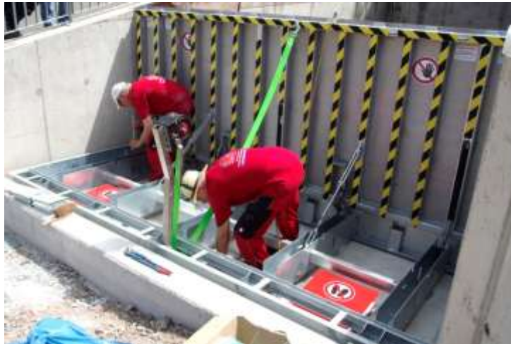
Während der Montage
