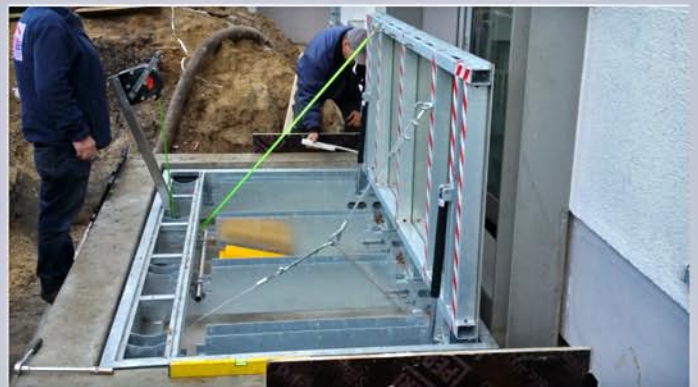
Einbau eines Klappschotts
