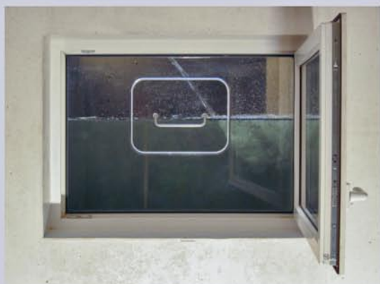
Hochwasserschutzfenster Manuell Standard im Einsatz
